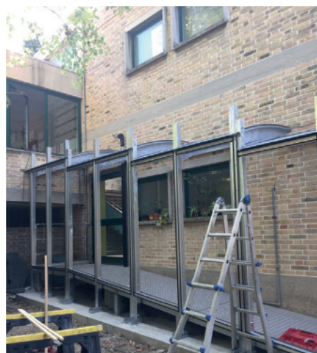
Scuola primaria e infanzia Castelnuovo: manutenzione ordinaria, installazione nuova pensilina, asfaltatura e manutenzione verde
