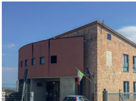
Scuola primaria Pittura del Braccio: adeguamento norma antincendio, nuovo cancello di ingresso automatizzato.
