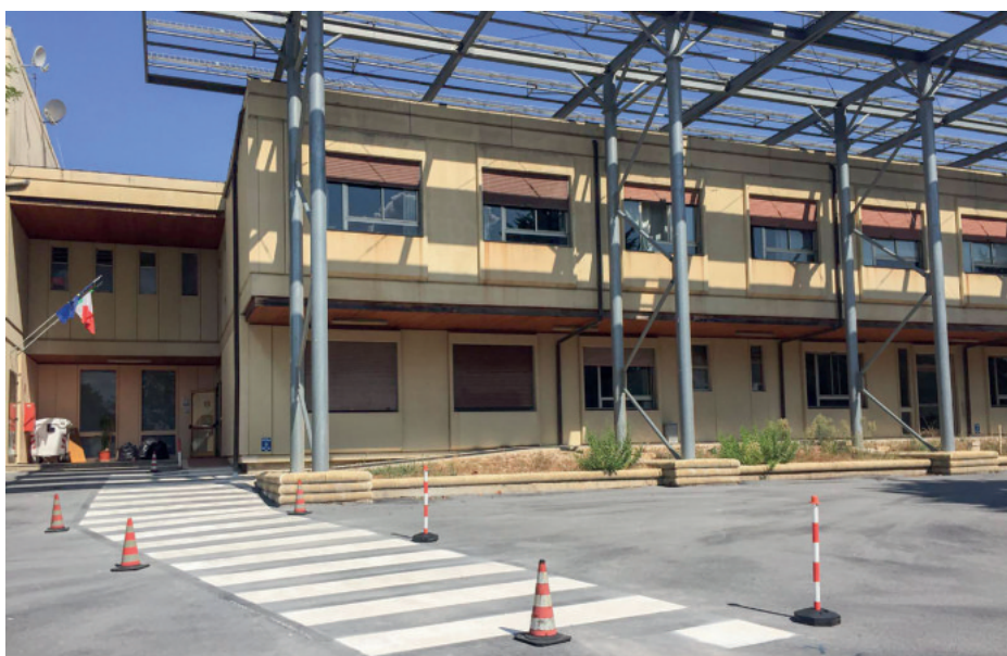
Scuola primaria Le Grazie: nuovo pavimento auditorium, impermeabilizzazione del tetto, asfaltatura.
