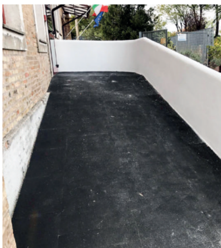
Scuola dell'infanzia di Montefiore: manutenzione ordinaria, tinteggiatura, sistemazione area verde, sistemazione rampa di accesso.
