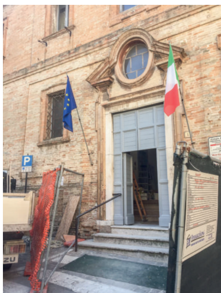
Scuola primaria e infanzia San Vito: adeguamento norma antincendio
