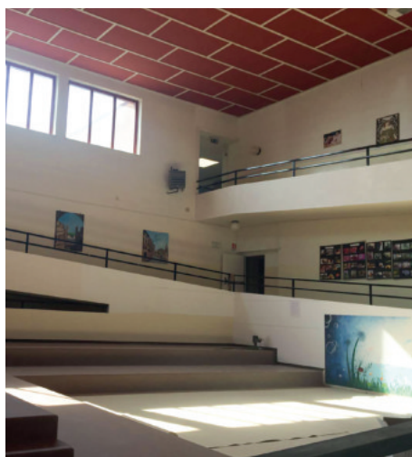
Scuola Media Patrizi: manutenzione ordinaria , rifacimento pavimentazione, auditorium, verifiche tecniche impianti.
